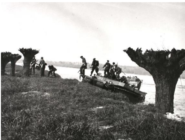
Geland aan de overzijde
